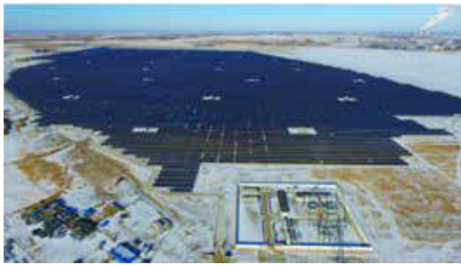
遼寧康平光伏電站
