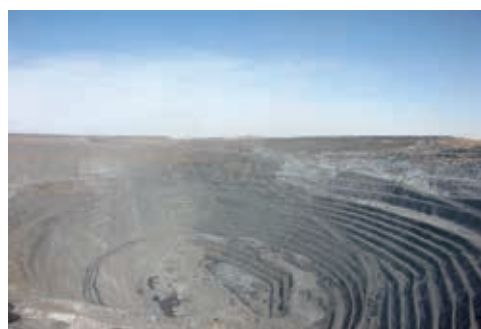
內蒙古太平加強露天采坑邊坡治理
