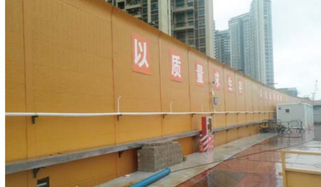
深圳润玺一期的隔音围挡
