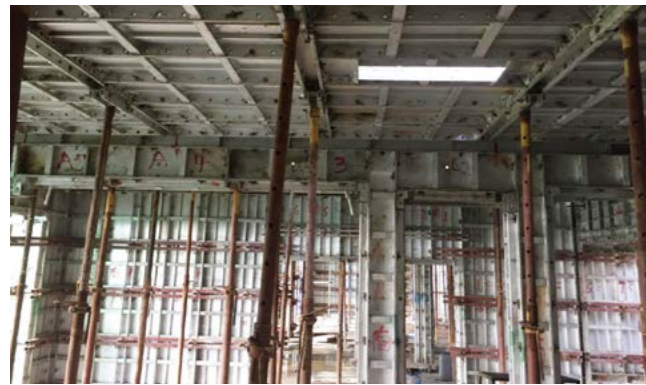
海南石梅湾项目 - 铝模施工
