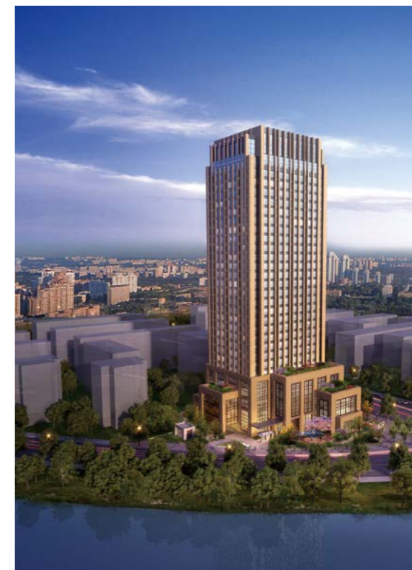
沈阳润馨汇项目
