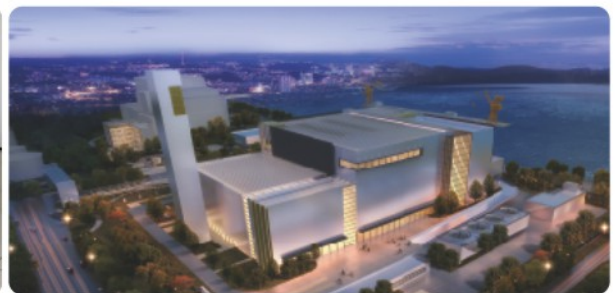
常熟浦發垃圾焚燒餘熱鍋爐項目
