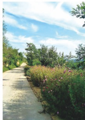
修建一新的鄉村公路
