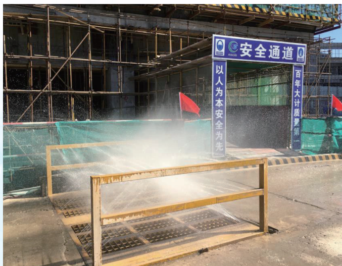
施工場地會設置安全通道及地面灑水除塵設備
