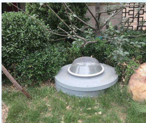
在建工程項目設置太陽能採集燈
