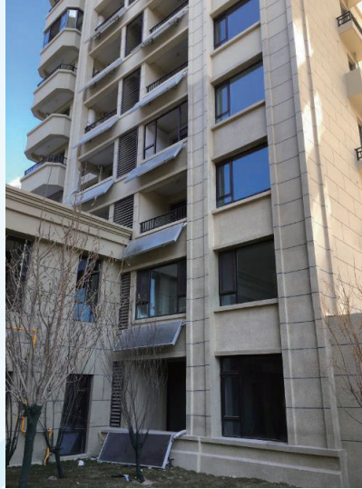
安裝太陽能發電板
