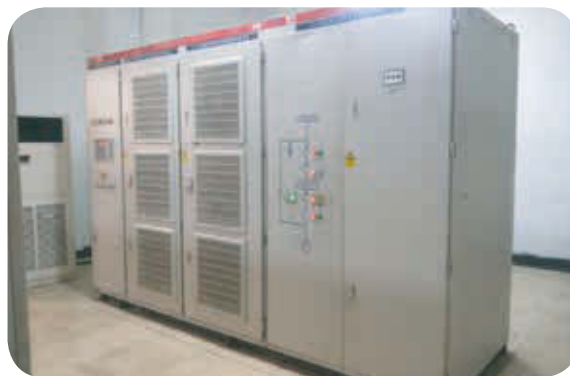
漿液循環泵電機加裝變頻器
