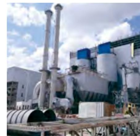
CMEC 所属中国电力工程有限公司承建的埃塞俄比亚莱比垃圾发电项目是非洲第一座垃圾发电厂，日均处理 1280 吨生活垃圾，可以将整个亚的斯亚贝巴城市环卫系统每天收集的垃圾消化掉。2018 年 7 月 2 日，该项目两台机组先后成功完成吹管，标志着非洲大陆第一座垃圾发电厂开始焚烧处理垃圾，这将成为这片土地上固废处理发展进程的一个历史转折点。同时，埃塞俄比亚莱比垃圾发电项目使用全套的中国标准和设备，将中国在绿色环保领域的成熟技术和经验引入非洲，为非洲城市化发展提供了新思路。该项目是埃塞参与国际碳排放交易的两个绿色能源项目之一，执行最严格的欧盟 2000 环保标准。
