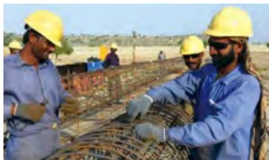
▲三位巴基斯坦技工在工作中学习到中国的钢筋绑扎和焊接技术
