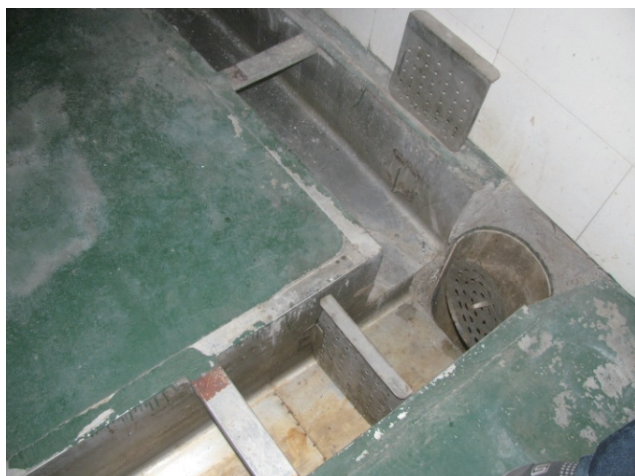
屠宰場內排放廢水的排水溝
