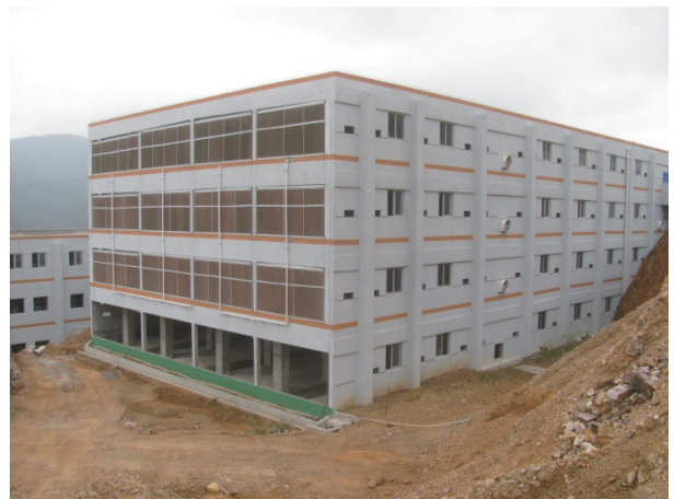
通風順暢的養豬欄結構
