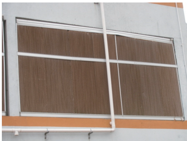
外牆開口處安裝蒸汽冷卻板
