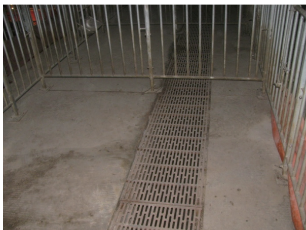
養豬欄內用於排放廢水的排水渠
