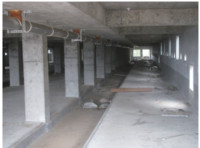
養豬欄內排水渠結構
