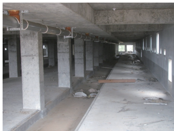
養豬欄內排水渠結構
