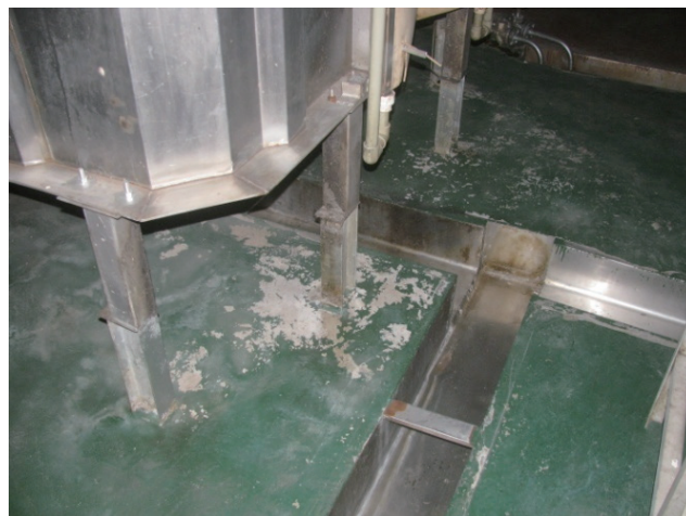
屠宰場內排放廢水的排水溝
