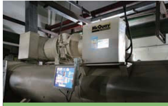
中央空調冰蓄能改造工程
