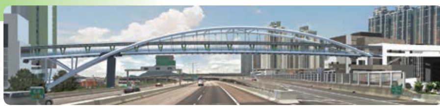
145米的鋼造拱橋
