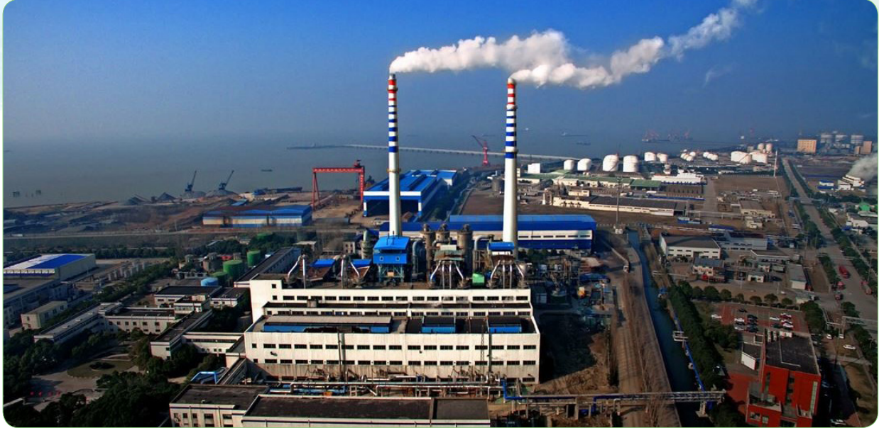
湛藍天空下的江蘇南通熱電聯產項目
