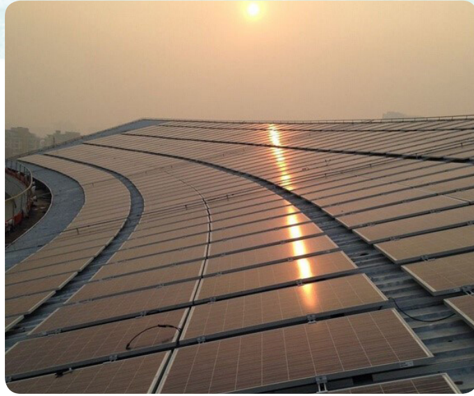
城市里的嘉興光伏項目
