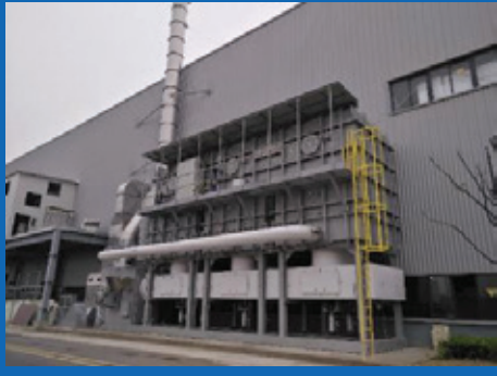
淮安區塗裝線VOC(揮發性有機化合物) 廢氣處理RTO系統
