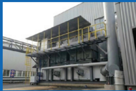
天津敏信機械有限公司新建塗裝項 目採用先進RTO焚燒處理工藝
