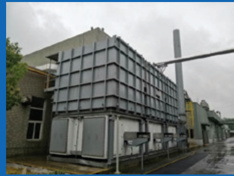
嘉興敏勝汽車零部件有限公司塗裝 線靜電噴塗廢氣由原有的活性炭吸 附方式，全部改為RTO
