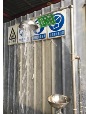
圖2：固定式緊急沖淋裝置
