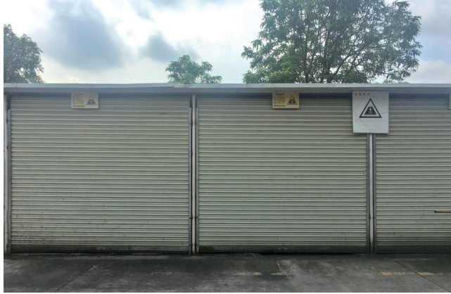
廠房外已設置生產廢料存放區
