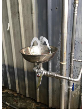
圖1：固定式緊急沖淋裝置
