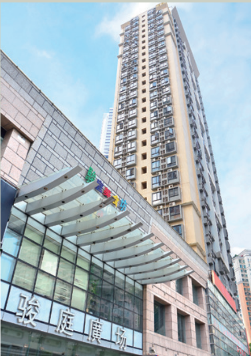
Shenzhen Imperial Palace Shopping Mall 深圳駿庭廣場
