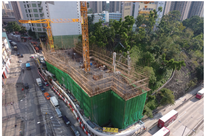
葵涌健全街葵涌市地段第495號 – 建築工程進行中
