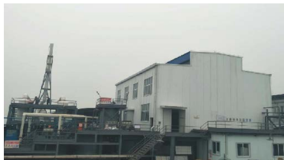
氰化尾渣無害化處理設備
