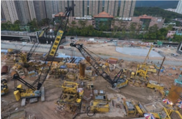
位於鑽石山之地基打樁工程
