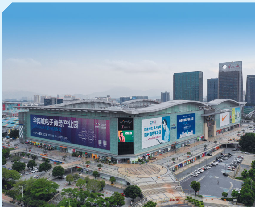
Trade center plaza 1 in CSC Shenzhen 於深圳華南城內的1號交易廣場
