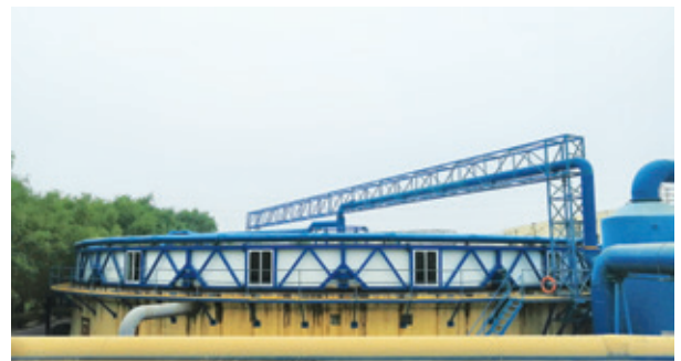
污水廠廢氣收集
