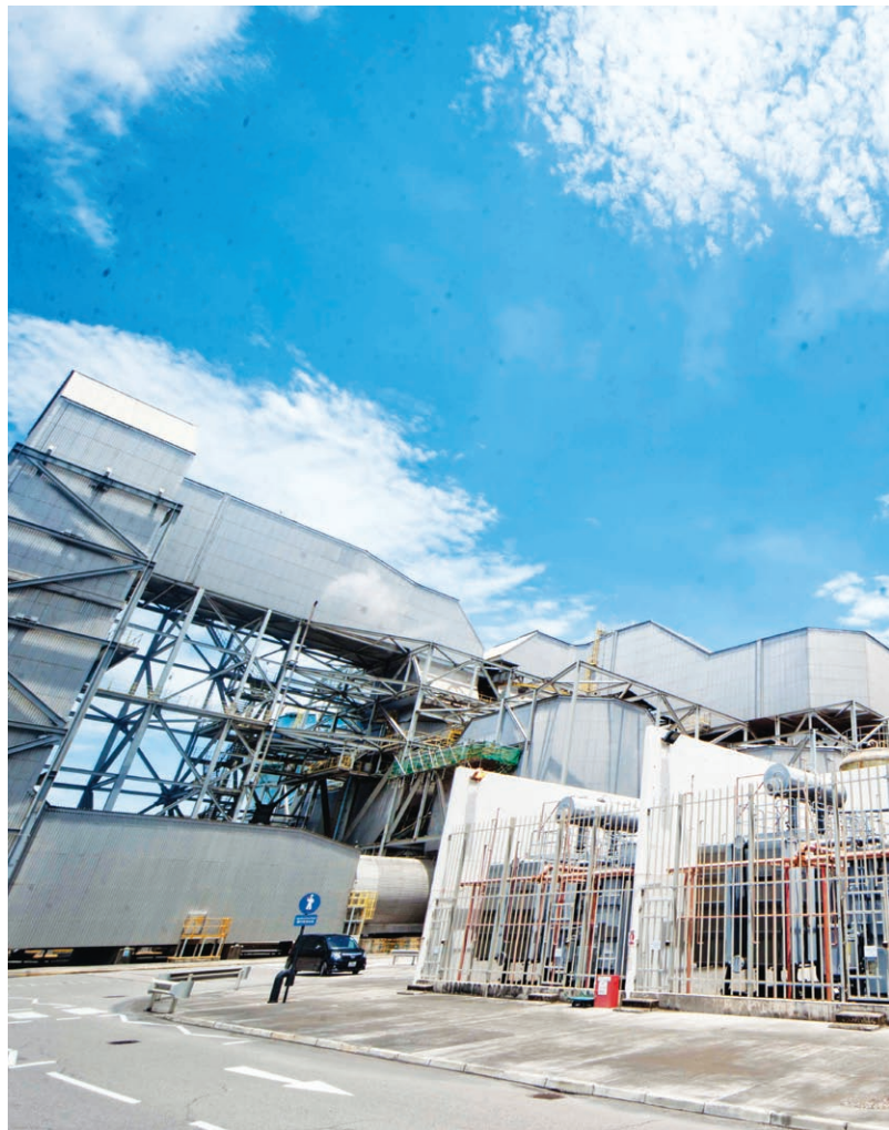
中華電力發電廠維修保養工程
