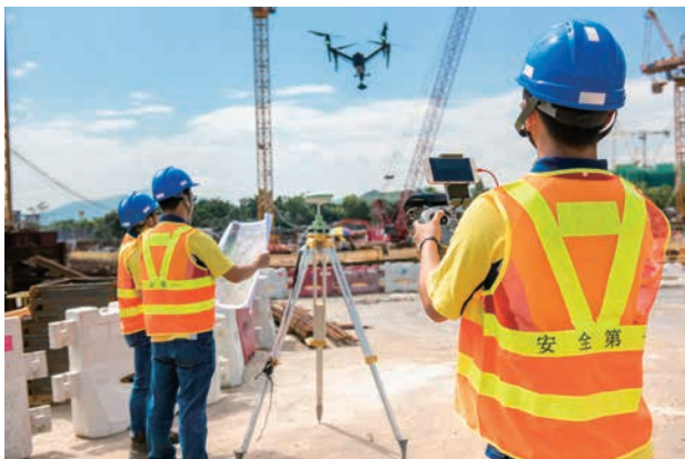
○ 利用無人機監察地盤進度
