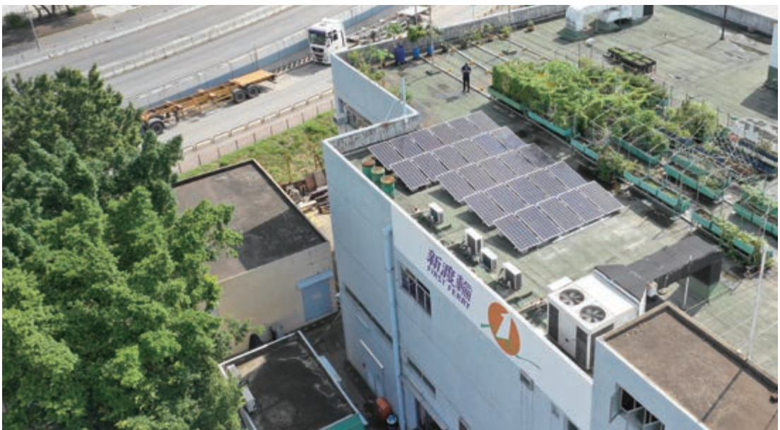
位於新渡輪長沙灣辦公大樓天台的太陽能板。
