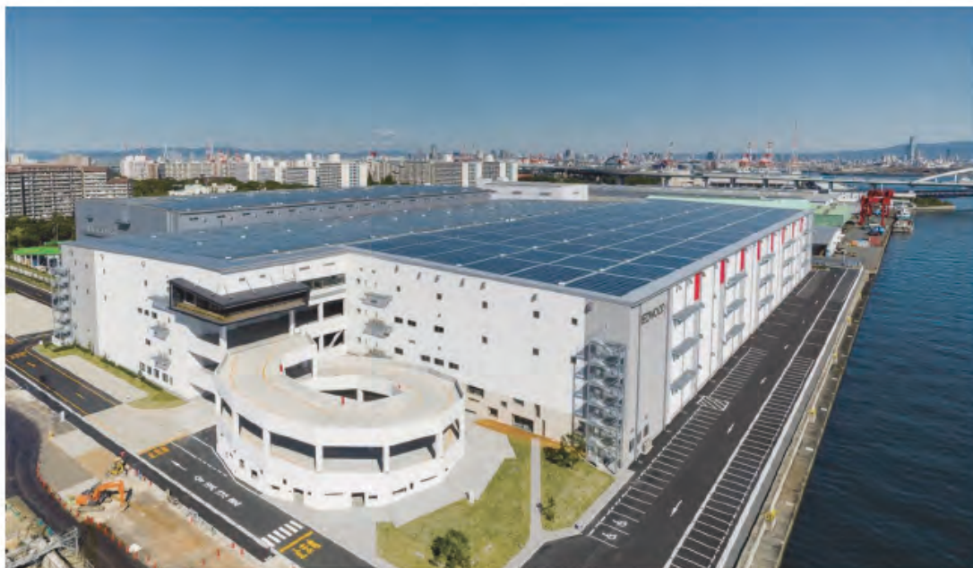
Nanko一期(日本)(由我們管理的基金持有)位於大阪港戰略位置，為雙坡道多層配送中心。 該設施於2016年竣工，樓高四層，建築面積為125,813平方米。
