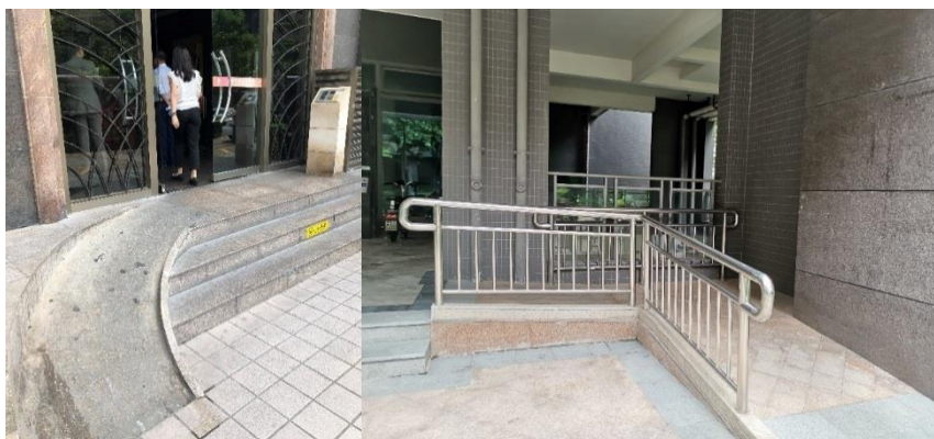
於城市天地廣場(左)及雅瑤綠洲(右)增設斜道
