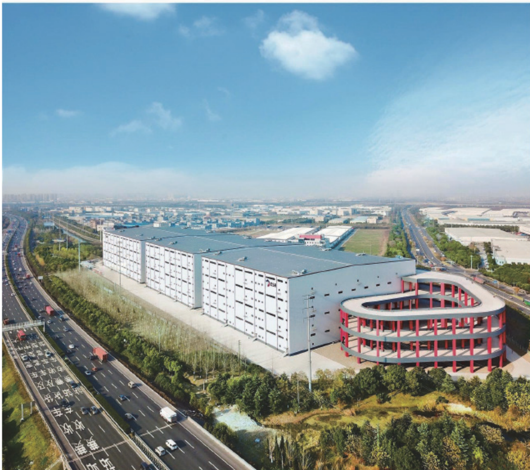
江蘇富萊德三期(中國)(由我們直接持有)位於江蘇省，為多層坡道配送中心。 該設施於2017年竣工，樓高四層，建築面積為206,418平方米。
