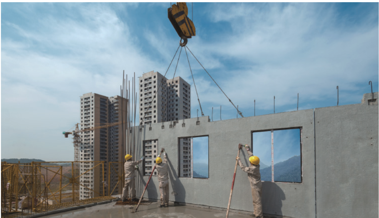
▲ 我們的產品（預製牆板）正在吊裝
