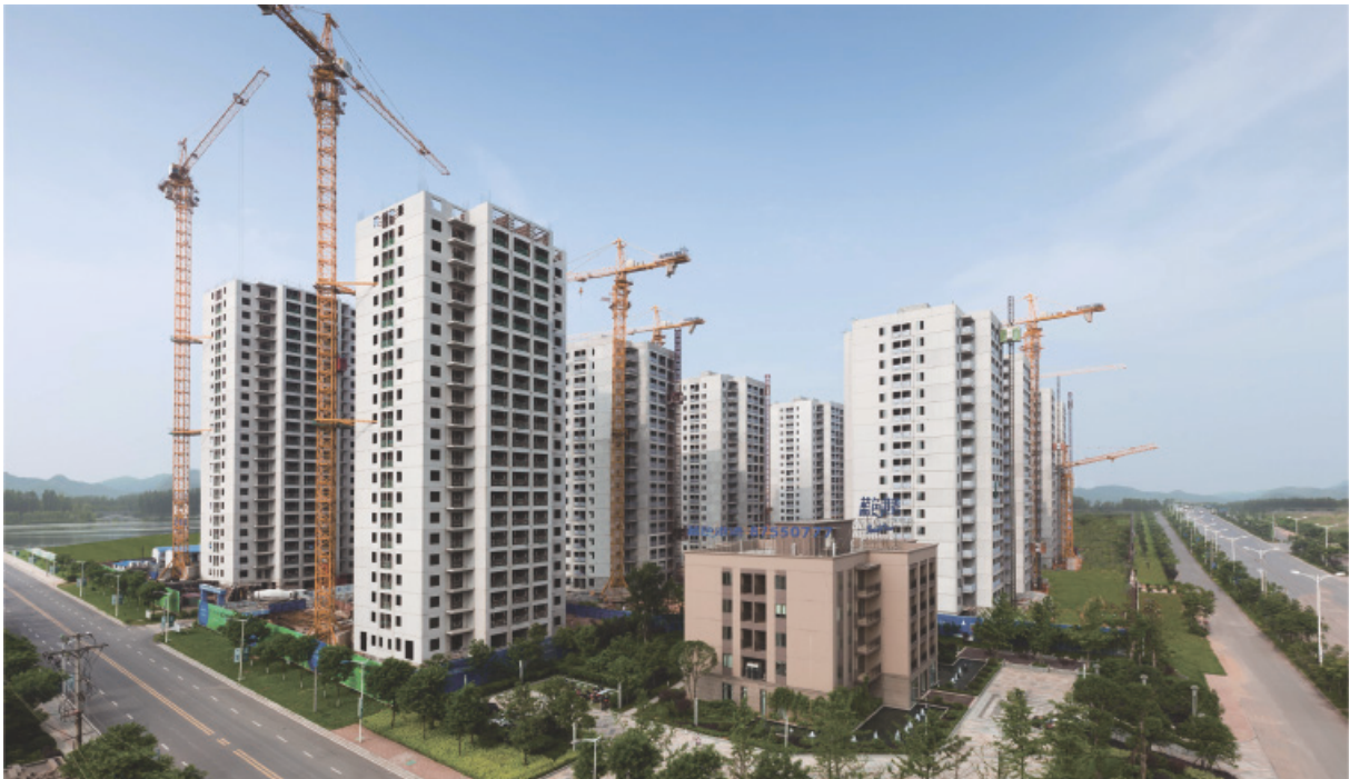
▼ 在建裝配式建築：位於湖南省寧鄉市的藍灣住宅建築 一期 竣工時間：2013年4月
