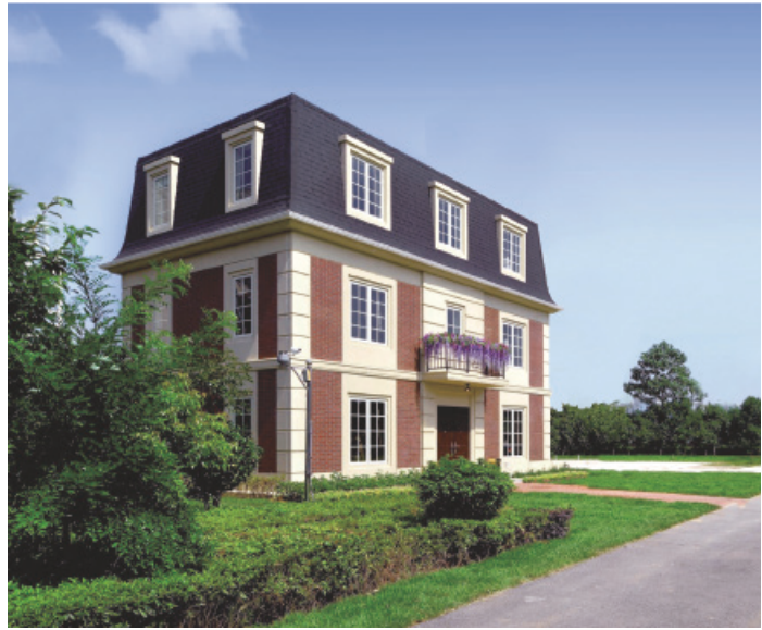
▲ 全裝配式別墅：位於湖南省長沙市的楓丹白露別墅 竣工時間：2015年6月
