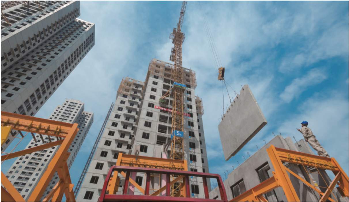
▲ 我們的產品（預製牆板）正在吊裝
