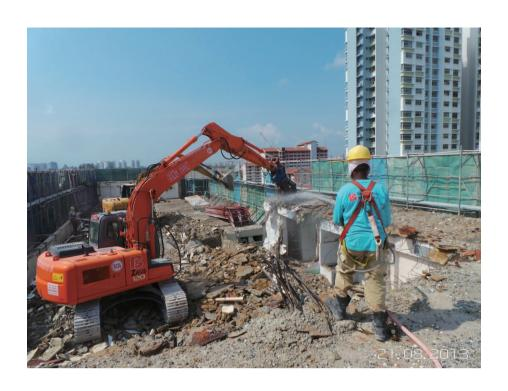
構築物拆除服務指通過應用壓碎、破碎及切割等不同方法拆解及移除樓宇結構的 混凝土或金屬塊件或組件及整樓拆除。我們通常採用一種或多種拆除方法組合進行構 築物拆除。拆除方法的主要類別載列如下:
