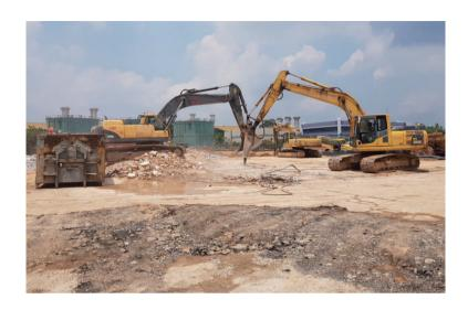
(iii) 切割一般指將鋼結構切成小塊的工序。我們一般使用液壓挖掘機所附帶的切割機開展有關工程。
