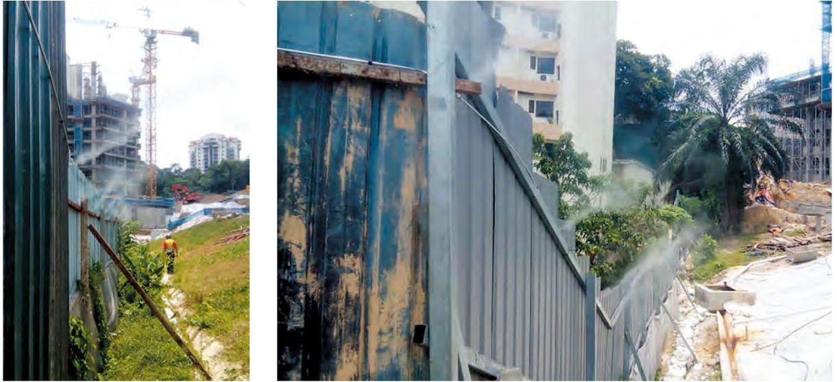
沿吉隆坡Sky Seputeh工地的分界圍籬設置細霧噴塗系統。該系統減少因建築活動產生粉塵造成的空氣污染帶到周邊社區。
