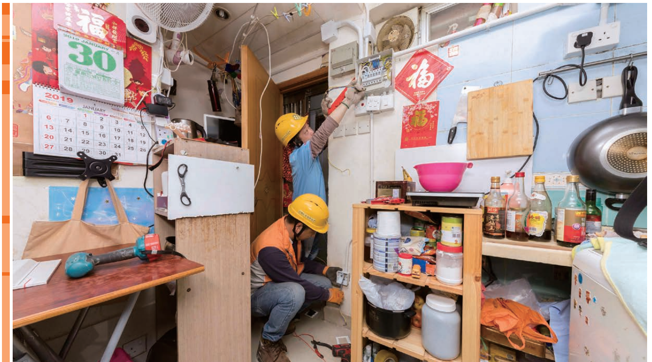
中電「全心傳電」計劃資助劏房戶的業主重鋪單位電線，以便安裝獨立電錶。
