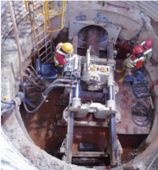
用於頂管施工的頂管機
