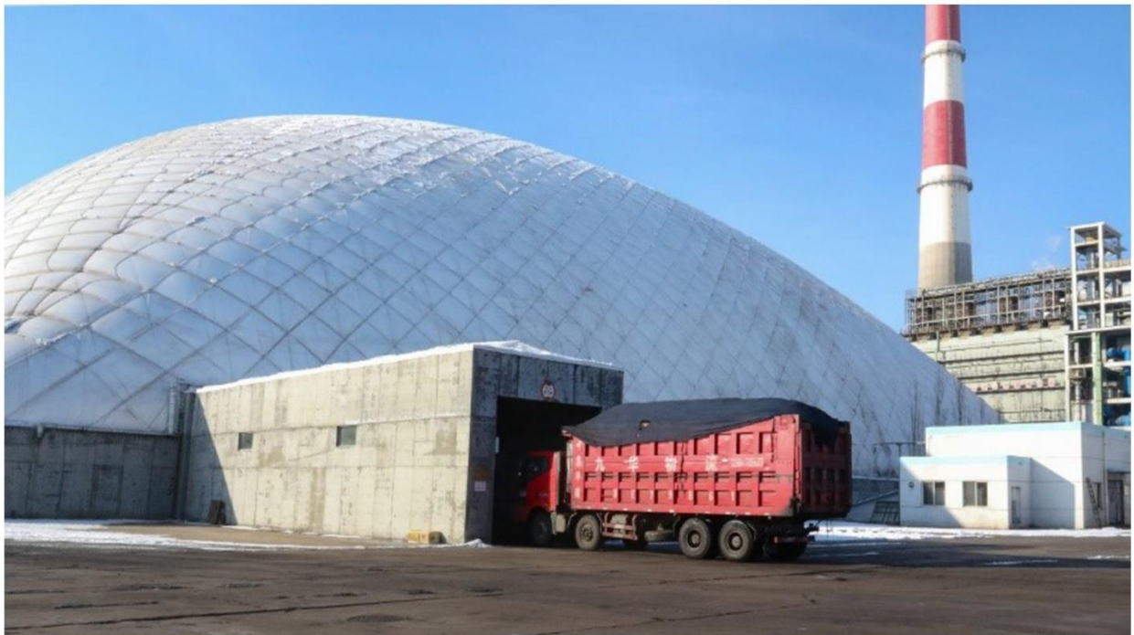
权属企业巴彦淖尔紫金公司通过建设全封闭储煤场，减少无组织粉尘
