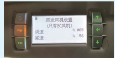
精密空調轉速上限統一設定為 85%，從而降低運行電流
