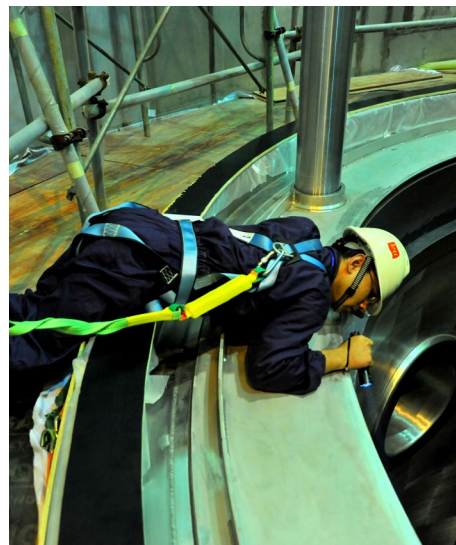
>>> 技術工人檢修設備
