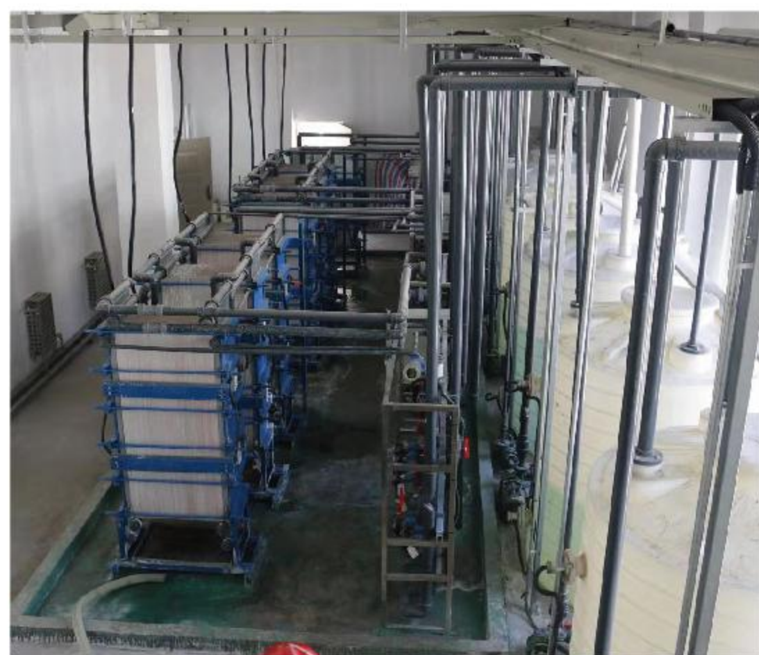
2019年，中国矿区开展二级RO产水代替离子交换自来水和锅炉软化水项目，改造后二级RO产水回收量为250立方米/天。
