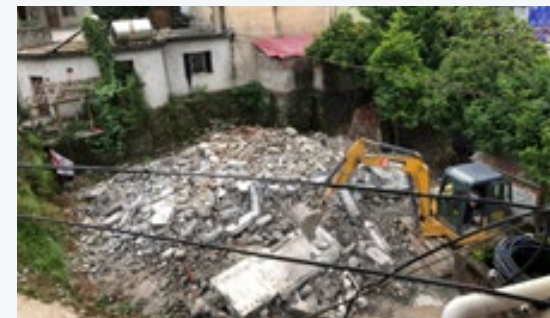
修建中的江口村卫生室
