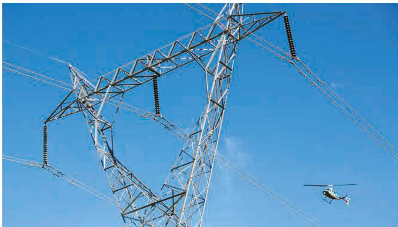
VPN 運用激光雷達技術進行高空檢查工作，確保網絡安全運作。
