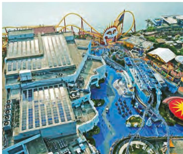
海洋公園支持發展使用可再生能源，在屋頂裝設太陽能發電系統，是港燈上網電價計劃內規模最大的商用可再生能源裝置。
