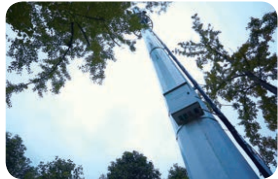
▲ 鐵塔塔桿布放空氣質量監測設備
