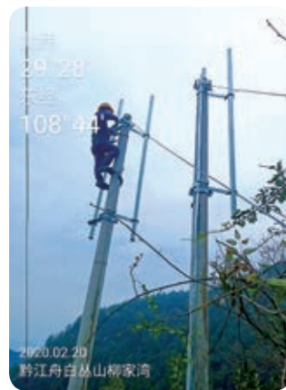
▲ 施工人員正在山區進行基站施工
