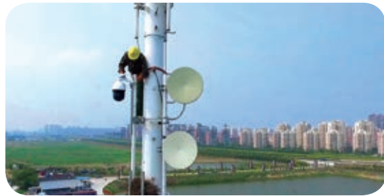
▲鐵塔塔桿布放高清監控設備
