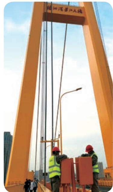
▲ 跨江大橋施工現場
