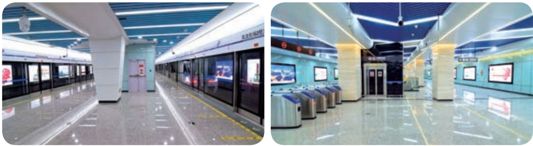
▲成都地鐵10號線5G網絡室分覆蓋
