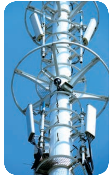
▲ 鐵塔上安裝紅外夜視攝像機
