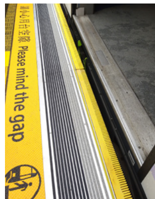
在豐景園站安裝並 試行易達斜台
