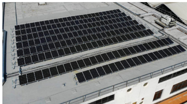
港鐵紅磡辦公大樓裝設的太陽能板
