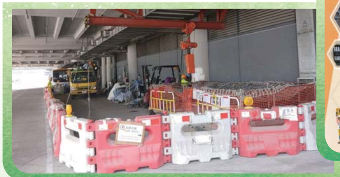
Our site workers used shed nets to wrap site materials 我們的地盤員工使用棚網包裹地盤材料
