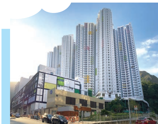
◀ Construction of Public Rental Housing Development at Fo Tan (in Sha Tin Areas 16 & 58D) Phases 1 & 2 位於火炭(沙田第16及58D區) 第1及第2期興建公屋發展項目
