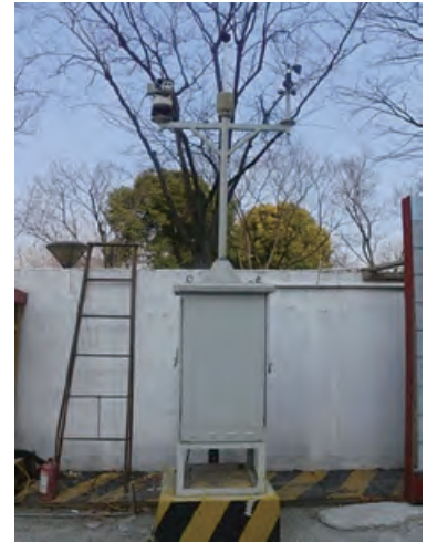
在建築地盤安裝分貝測量儀，監控噪音水平，每日進行數次隨機檢查，不定時記錄度數。
