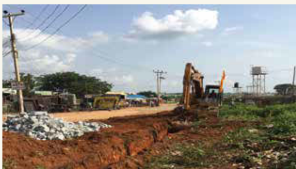
協助尼日利亞社區修建排水溝
