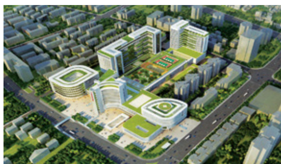
深圳南山醫院改造工程項目
