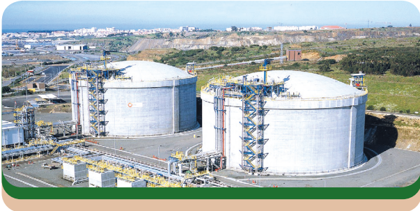
天然氣存儲基礎設施
