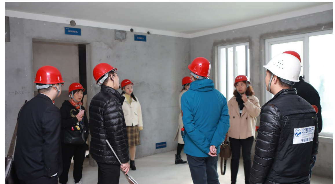
客户查看项目房屋施工质量
