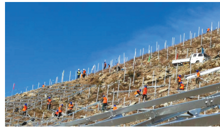
「遼寧朝陽500兆瓦光伏平價上網項目」正式開工建設。
