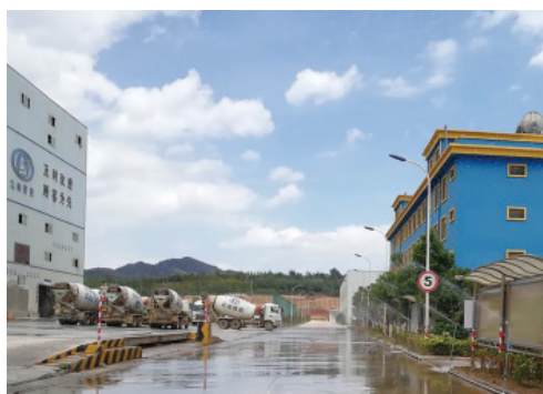
Road spraying system 道路噴淋系統
