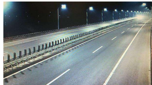
青山湖大橋LED燈照明改造工程
