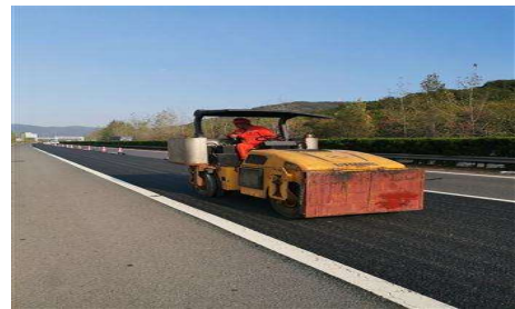
甬金管理處進行養護施工
