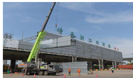
浙滬主線收費站動工拆除
