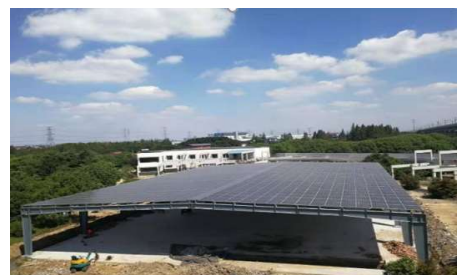
嘉興管理處安裝分佈式光伏電站
