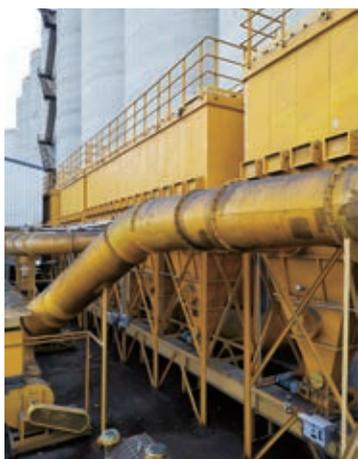
2019年，散糧碼頭公司對除塵器設備進行投資改造，進一步提升糧倉粉塵有組織排放管控水準。
